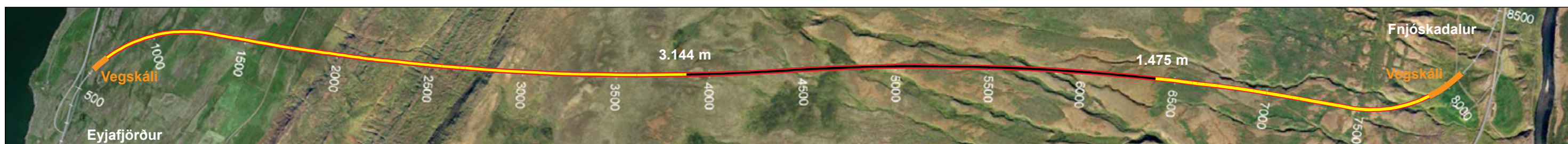
Vaðlaheiðargöng, staða framkvæmda 21. desember 2015. Búið er að sprengja samtals 4.619 m sem er 64,1% af heildarlengd.
